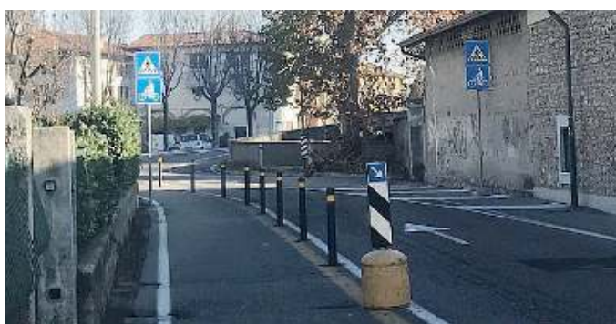
Una protezione. I paletti posizionati lungo via Castello a Castel Mella
